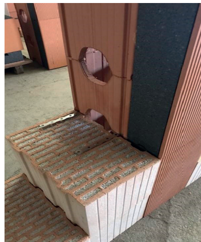
Poroton®-SDS® als Wandstütze
