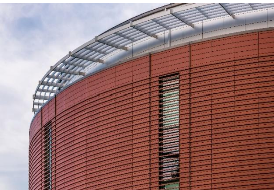
Vorgehängte hinterlüftete Fassade, Produktlinie Argeton: individuelle Sonderanfertigung (Foto: wienerberger)
