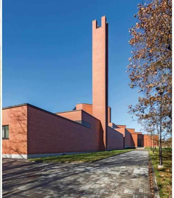
Durch die Renovierung erhielt das renommierte Theater eine komplett neue Außenhülle aus roten Ziegeln, die dem originalen Fassadenstein ähneln. Wo nötig, wurden Sonderanfertigungen eingesetzt.
