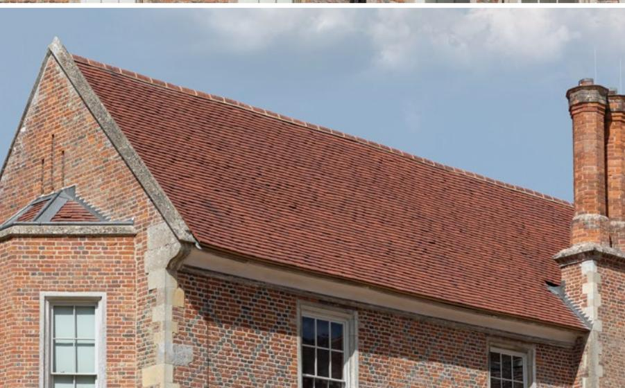
Nun arbeitet die Zeit an den Dachziegeln: Im Laufe der nächsten Jahre werden die Dachziegel durch die Witterung nachdunkeln und sich der originalen Optik immer weiter annähern.
