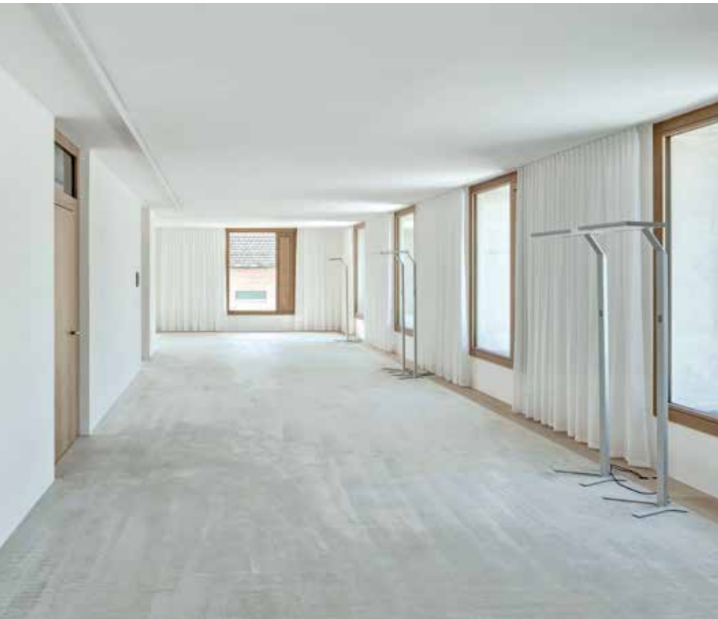
Rund um den massiven Kern gibt es eine breite nutzungsflexible Zone ohne Stützen oder tragende Zwischenwände.
