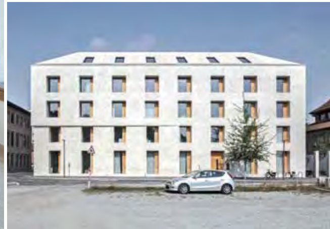
Eng abgestimmt mit der Denkmalpflege nimmt der Neubau in Grundfläche, Dachgestaltung und Kubatur wichtige Charakteristika des Vorgängerbaus auf.
