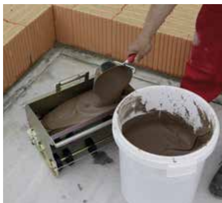
1.6a Befüllen der VD-Mörtelrolle
