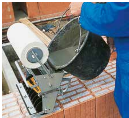
1.6c Einfüllen in die V.Plus-Mörtelrolle
