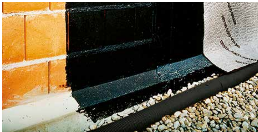
3.7 Einschalige Außenwand mit teilweiser Abdichtung
