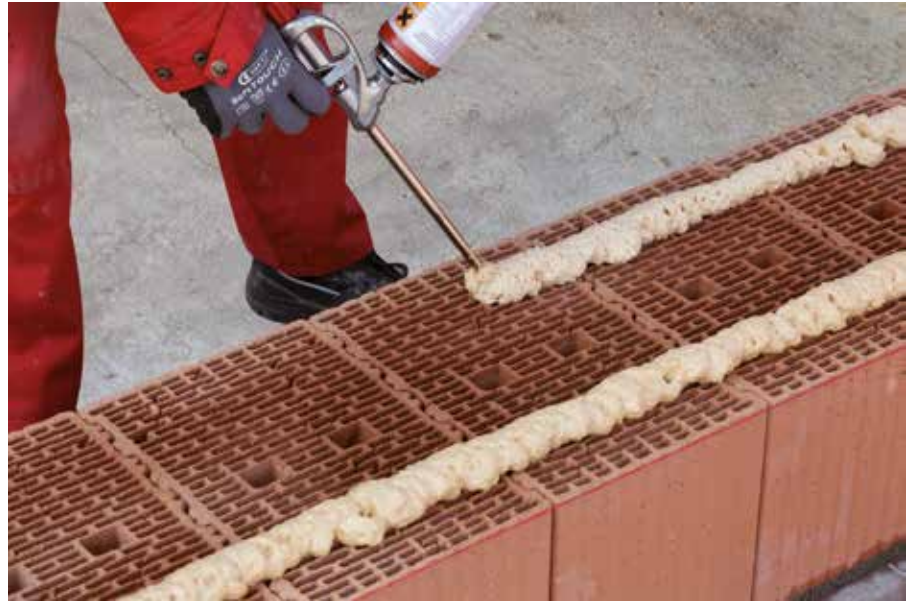
1.7 Arbeiten mit dem POROTON Dryfix System
