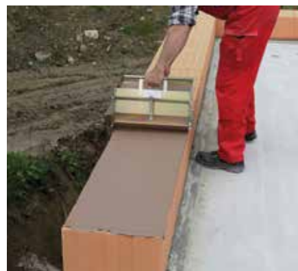
1.6b Auftragen des deckelnden Dünnbettmörtels mit der VD-Rolle
