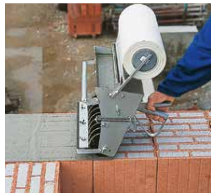
1.6d Auftragen des deckelnden Dünnbettmörtels mit dem V.Plus-Verfahren
