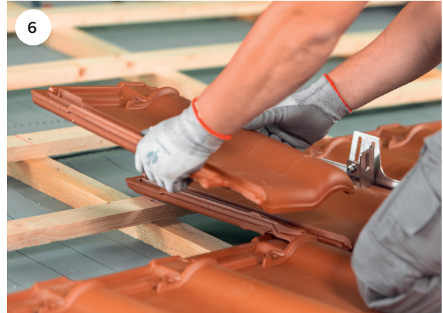
Eindecken der weiteren Flächenziegel bis hin zur nächsten Position der weiteren Multi-Solarhalter.
