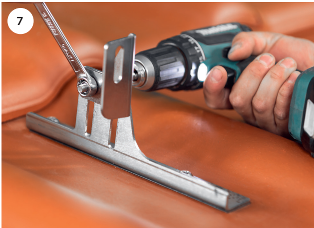
Positionieren und Anschrauben des Aufnahmewinkels für die PV-Schienenbefestigung. Die Schrauben werden mit einem Ringschlüssel der Größe 13 mm und mit einem Bit T40 angezogen. Vertikale Ausrichtung für die Schienenmontage von vorne.
