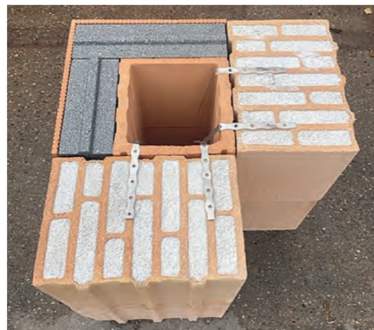
Poroton®-SDS® als Eckzugstütze
