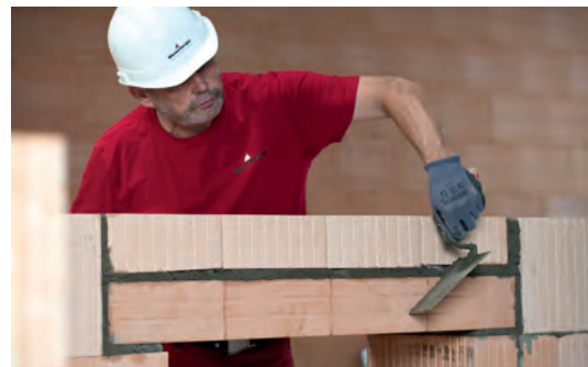
Höhenausgleichsziegel im Sturzbereich.
