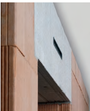
Im Kasten vormontierter Luftdurchlassschlitz
