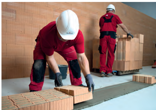
Höhenausgleichsziegel werden idealerweise bereits in der ersten Schicht versetzt, mit der geschliffenen Seite nach oben.
