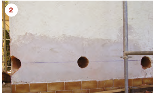
2 Der Abstand der Konsolen richtet sich nach der Art des Untergrundes und der Übermauerungshöhe (siehe Tabelle).
