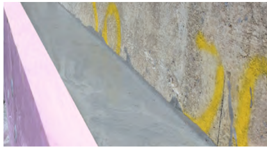
Bild 2: Mit Vergussbeton oder fließfähigem Normalbeton ( \geq C20/25 ) wird nun der Ortbetonbalken als Aufstandsfläche für Poroton-WDF erstellt. Die Vormauerung muss mindestens zur Hälfte auf der Betonfläche aufliegen. Die Perimeterdämmung dient als verlorene Schalung.
