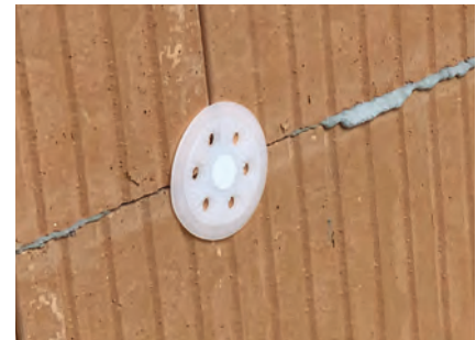
Bild 3: Verschlussstopfen einfügen, fertig.
