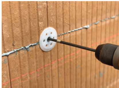
Bild 2: Den Schraubkopf nur bis zum Ende des dickeren Dübelschafts eindrehen. So entsteht kein Druck auf die Vormauerschale. Um ein zu tiefes Eindrehen der Schraube zu verhindern, wird die Setztiefe am Setzwerkzeug markiert und das Drehmoment am Schrauber reduziert.
