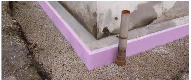
Fundament mit Perimeterdämmung
